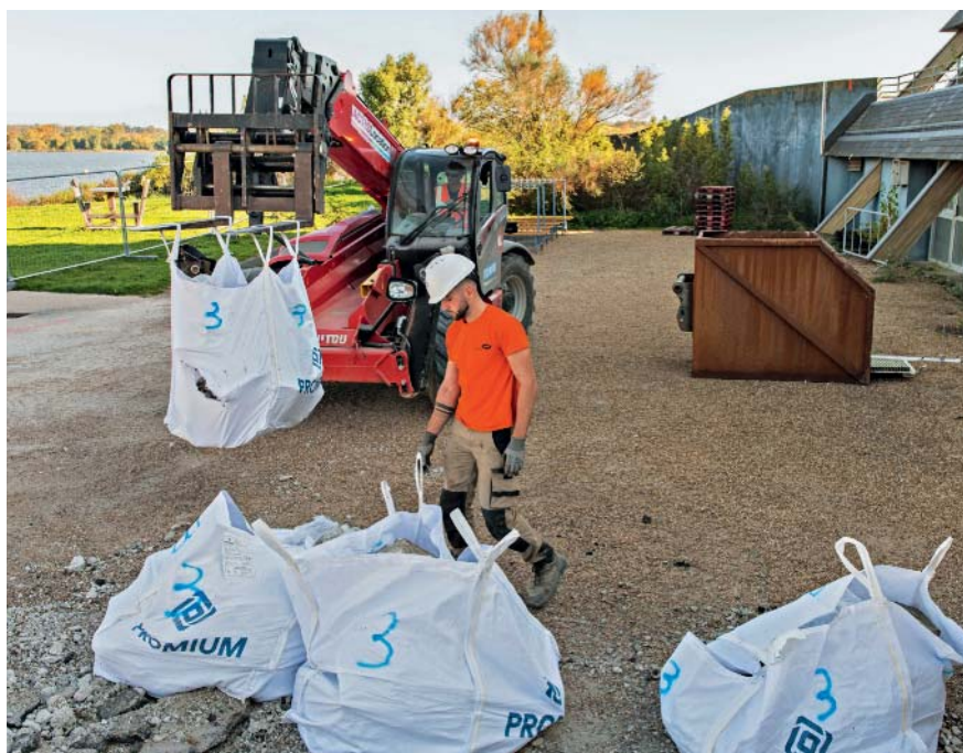
Les pavés du parvis de la pyramide sont prélevés pour être réemployés.
