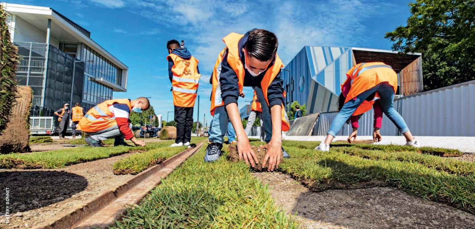
La subirrigation est expérimentée sur les premiers kilomètres de la nouvelle ligne de tramway, boulevard Lakanal, dans le quartier Belle-Beille, à Angers.
