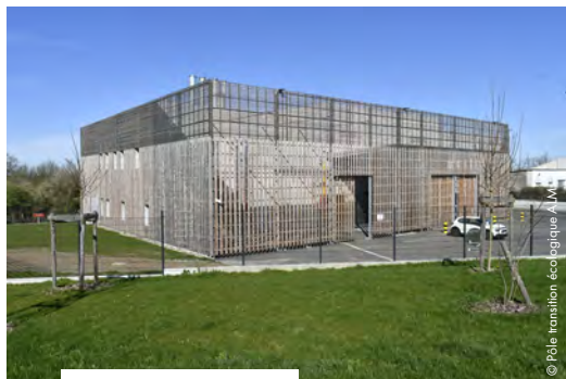
La nouvelle chaufferie de Monplaisir.
