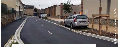
Les places de stationnement en dalles alvéolées permettent l'infiltration des eaux pluviales.
