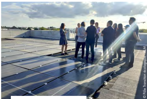
Balade solaire sur la toiture de la Maison de quartier des Hauts de Saint-Aubin.
