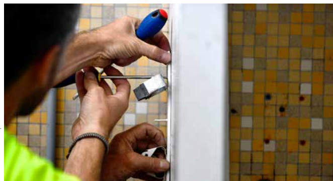
Ce chantier s'est accompagné d'une zone de gratuité éphémère à destination des riverains.
