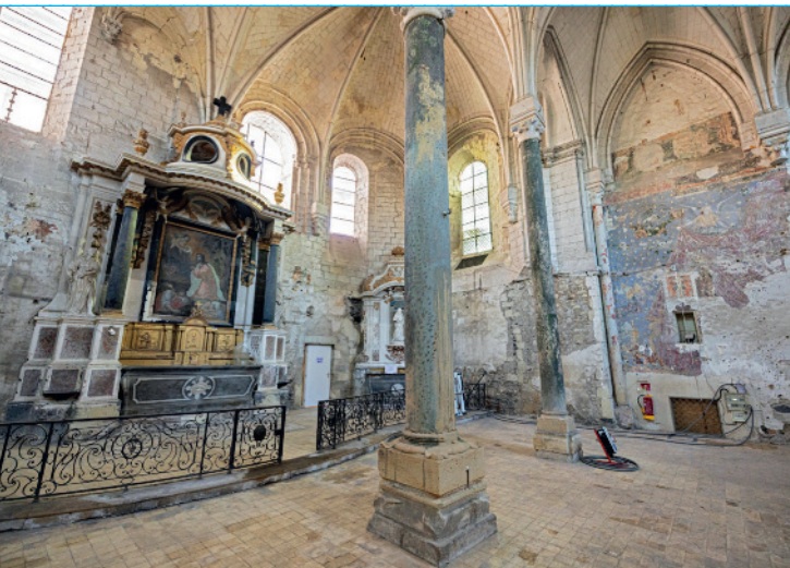
Les boiseries et les vitraux ont été déplacés de la chapelle Saint-Jean, en vue de leur restauration.
