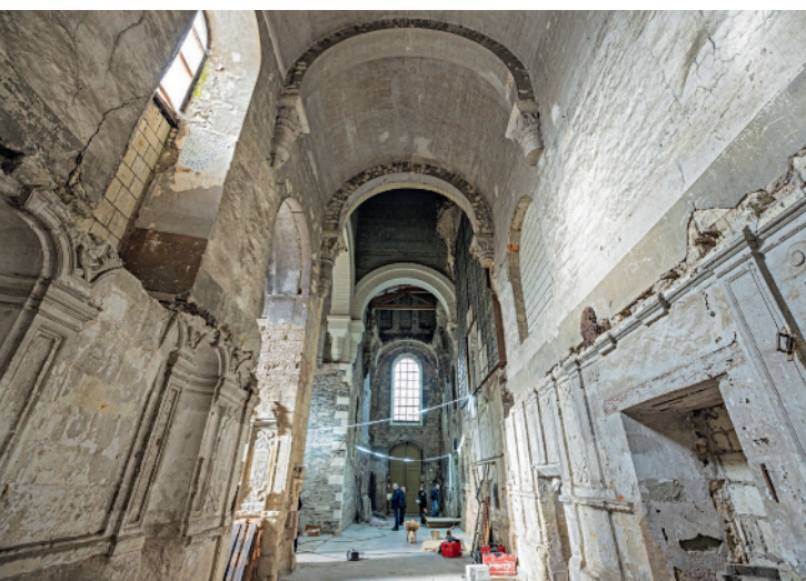
Le transept sud, qui donne sur la place de la Laiterie, deviendra l'espace d'accueil du public de l'église abbatiale du Ronceray.
