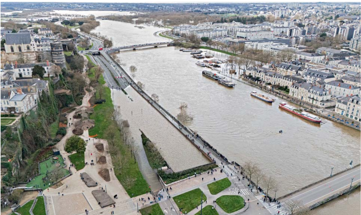
La crue a entraîné la fermeture du pont de Verdun et de la voie des berges, qui a été inondée pour diminuer la pression.
