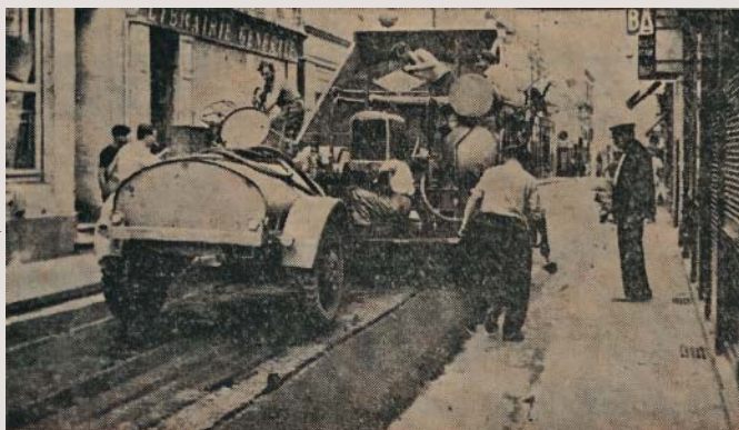
Opération de goudronnage à titre d'essai dans les rues d'Angers.
