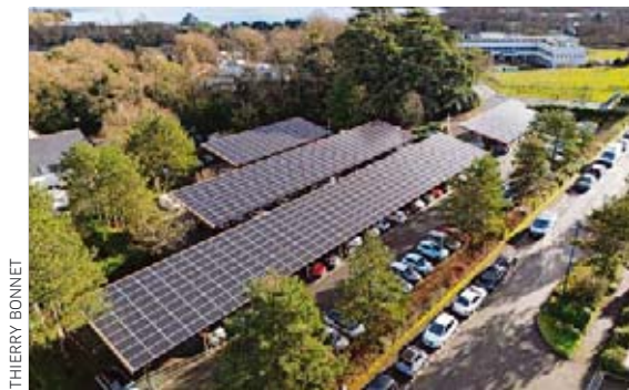
1600 m 2 de panneaux photovoltaïques recouvrent le parking de l'Ademe.
