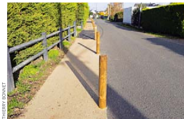
Un chemin piéton au revêtement perméable à Briollay.
