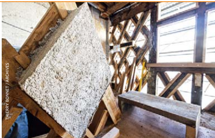
La maison d'Adam a été restaurée avec un enduit chaux-chanvre.
