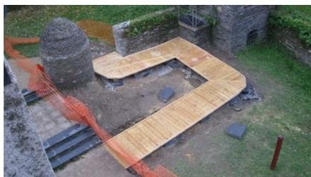
Désormais l'accès au jardin est possible via un portail de 3 m de large, puis le sol est stabilisé sur environ 21 m avant d'arriver à un dallage de 9 m de long qui aboutit au pied de la rampe (en bois, 12 m environ). A la sortie de la rampe, le cheminement est de nouveau sur sol stabilisé (arène granitique).
