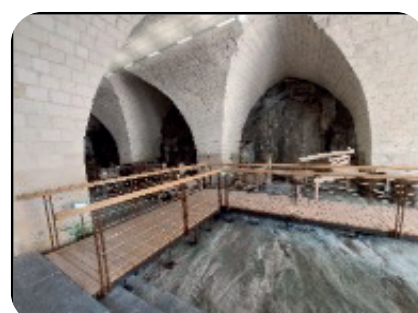
Photo : 3 vues différentes de la salle Sacavin, dont la passerelle en bois permettant la mise à niveau du sol
