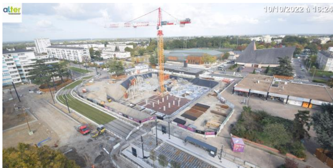
Construction du plot nord, rez-de-chaussée commercial et 60 logements (en cours depuis mai 2022)
