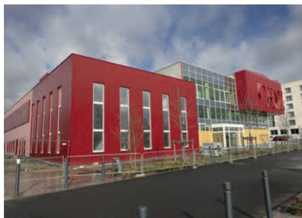
La maison de quartier des Hauts-de-Saint-Aubin
