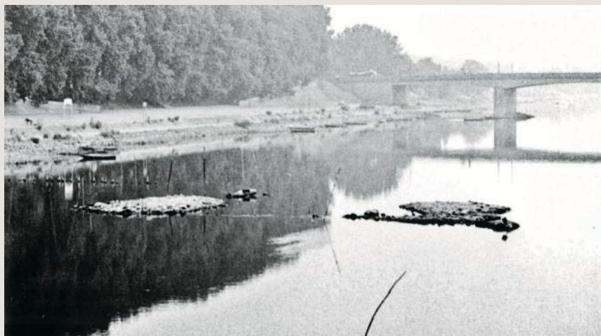
La Maine, juin 1976. Vestiges des piles du pont des Treilles, vue vers le quai Monge.
