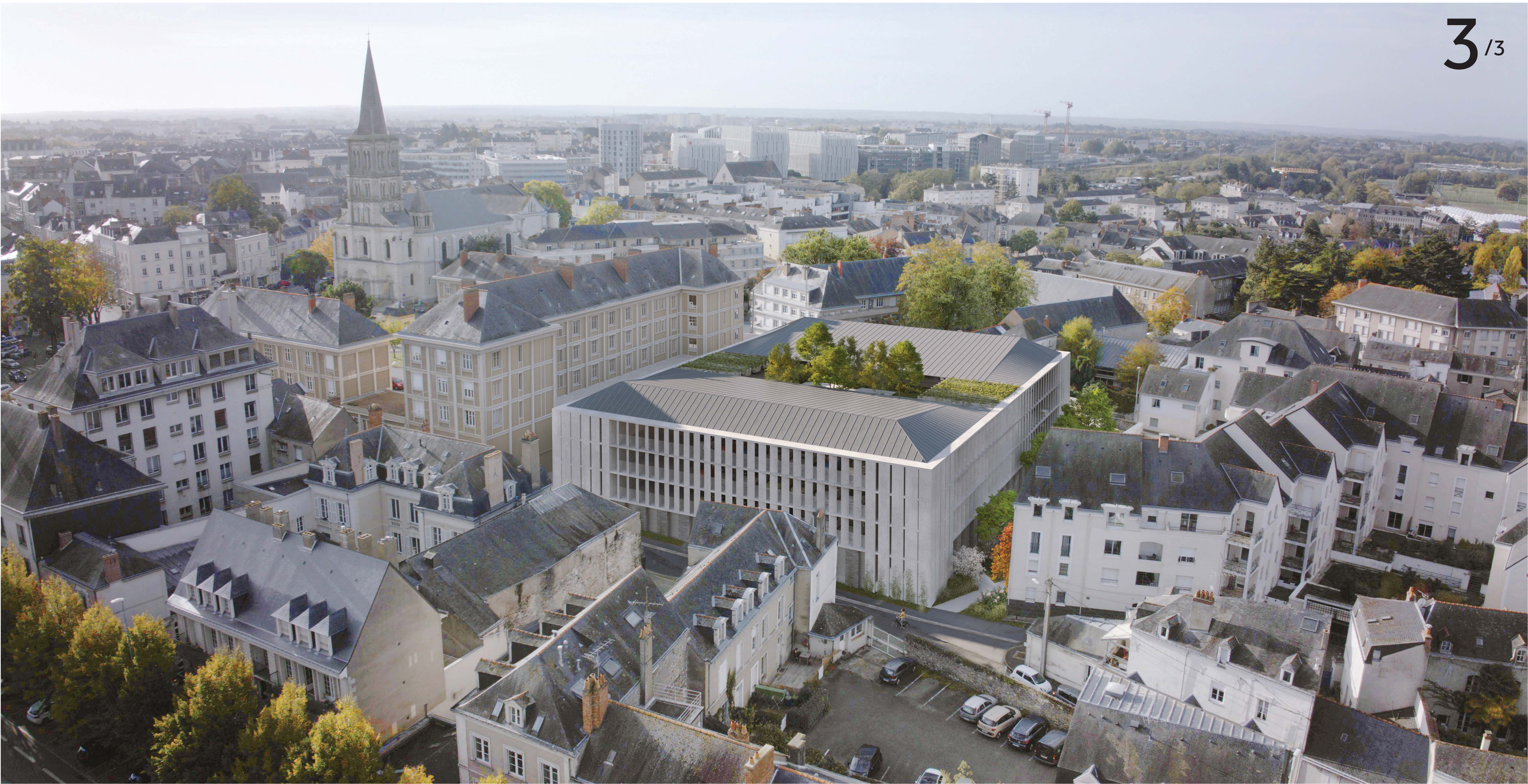
VUE AERIEENNE DEPUIS LES REMPARTS DU CHATEAU.
