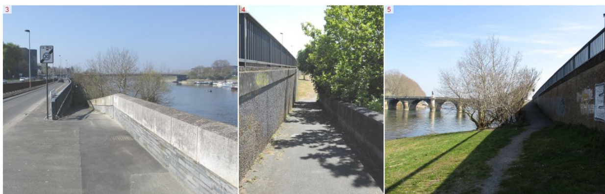
Accès au Pont de Verdun et à la place Poissonnerie par une rampe forte (8%)
