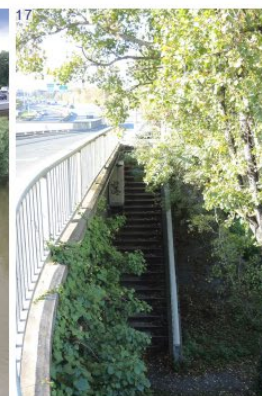
Un muret avec escalier fait obstacle à la promenade basse au niveau du pont Basse-Chaine. La liaison au Bd. du Général de Gaulle s'effectue par un escalier étroit. (Hors périmètre)
