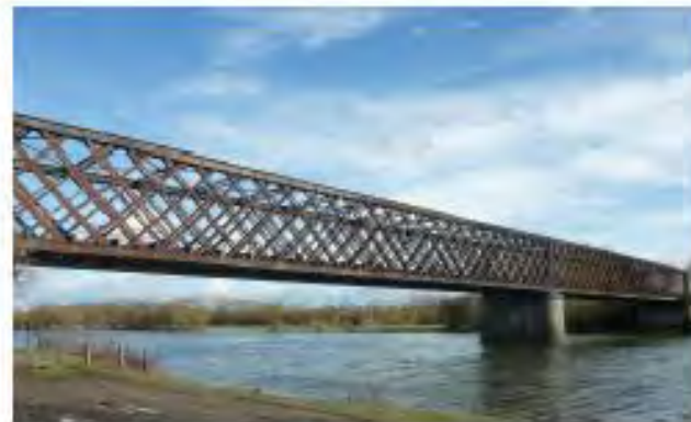
Pont de Segré
