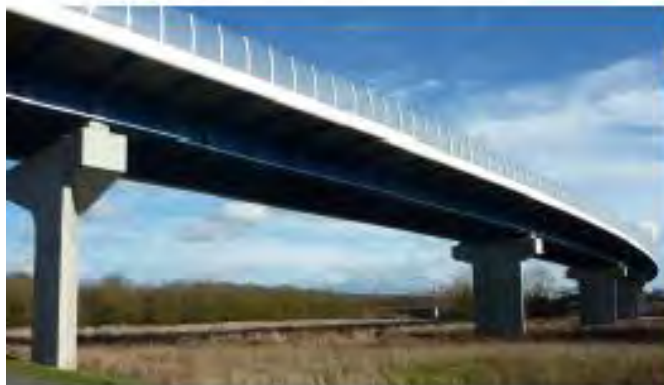
Viaduc de la Maine (pont de l'A11)
