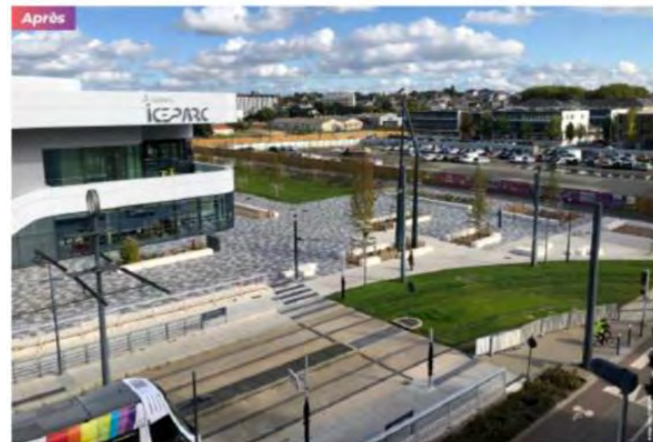
Figure 294 : Vues de la face Sud de la patinoire Iceparc avant/après travaux
