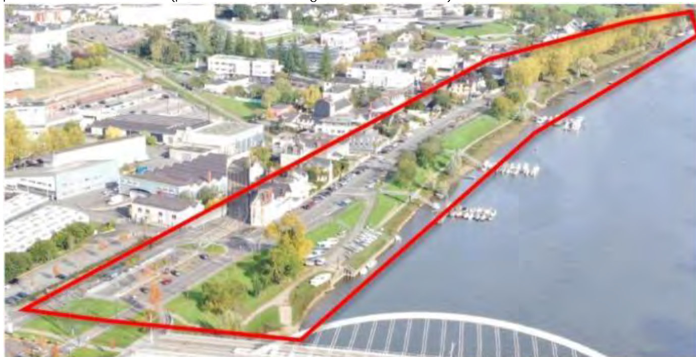
Figure 289 : Vue de la Promenade de la Reculée avant aménagement
