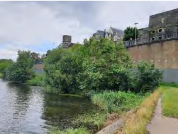
Saulaie blanche dégradée en amont du pont de la Basse Chaîne (27 juillet 2021)
