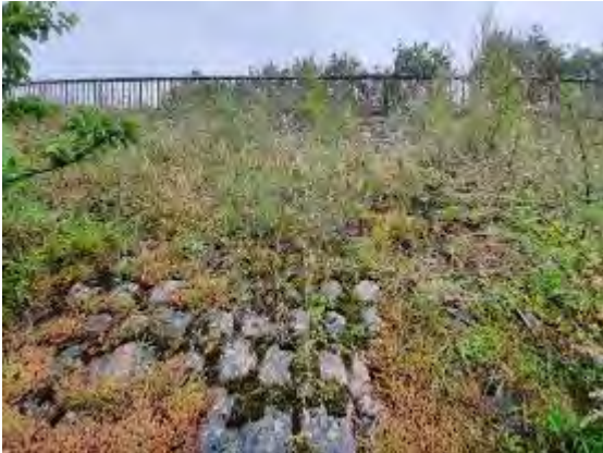
Perré maçonné en aval du pont de la Haute Chaine (27 juillet 2021)
