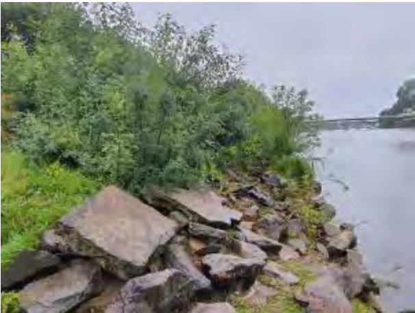
Forêt fluviatile mixte dégradée avec dalles bétons et enrochements (27 juillet 2021)
