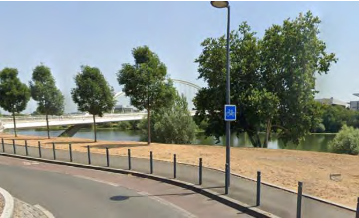
Figure 55 : Vue avant travaux du site projeté pour l'accueil de gradins béton Source : Google Street View, août 2021
