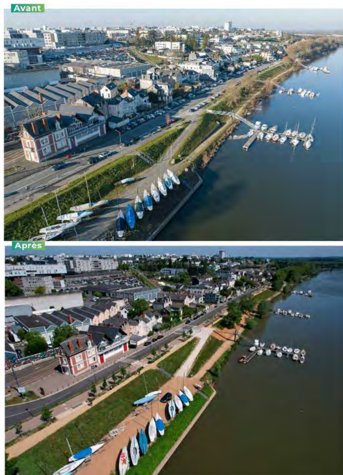
Figure 45 : Vues drone avant/après des aménagements Promenade de Reculée – cercle de voile
