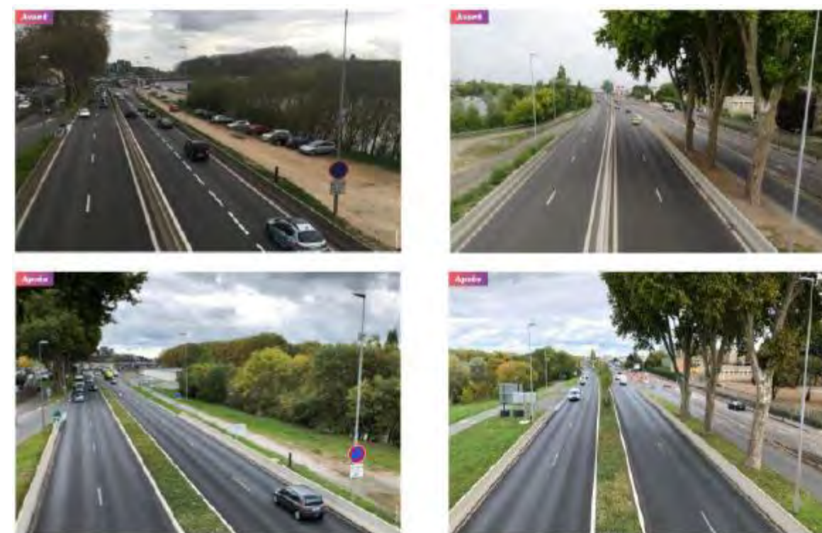
Figure 19 : Apaisement de la voie des berges – Boulevard de la Maine amont côté Saint-Serge AVANT/APRÈS
