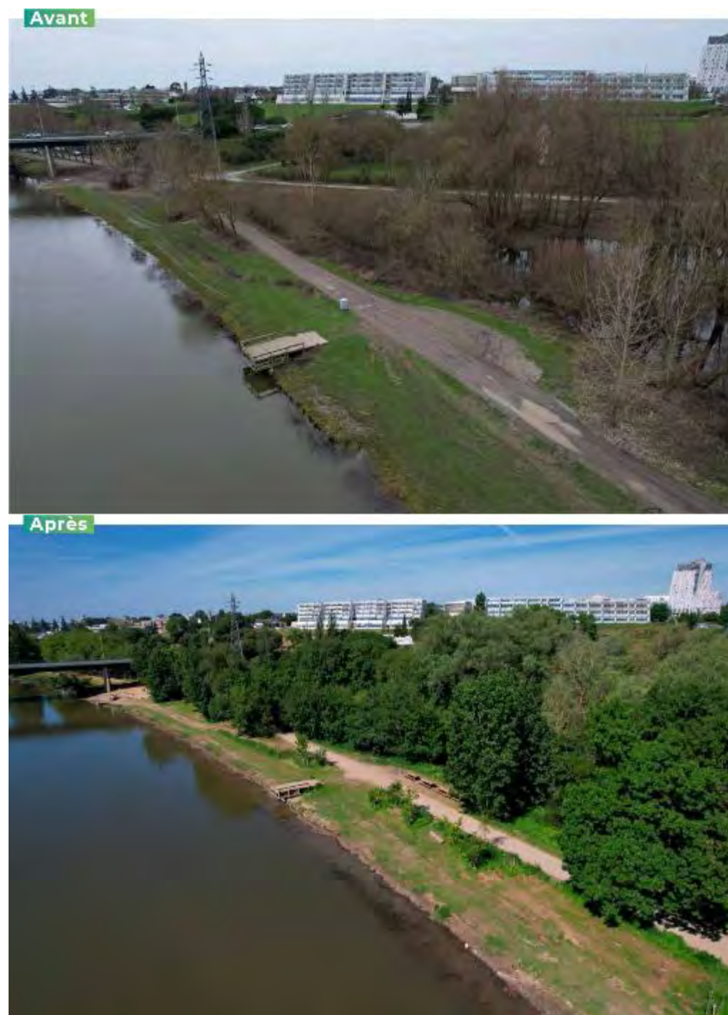
Figure 49 ; Vues drone avant/après des aménagements Promenade de Reculée – Saint Aubin
