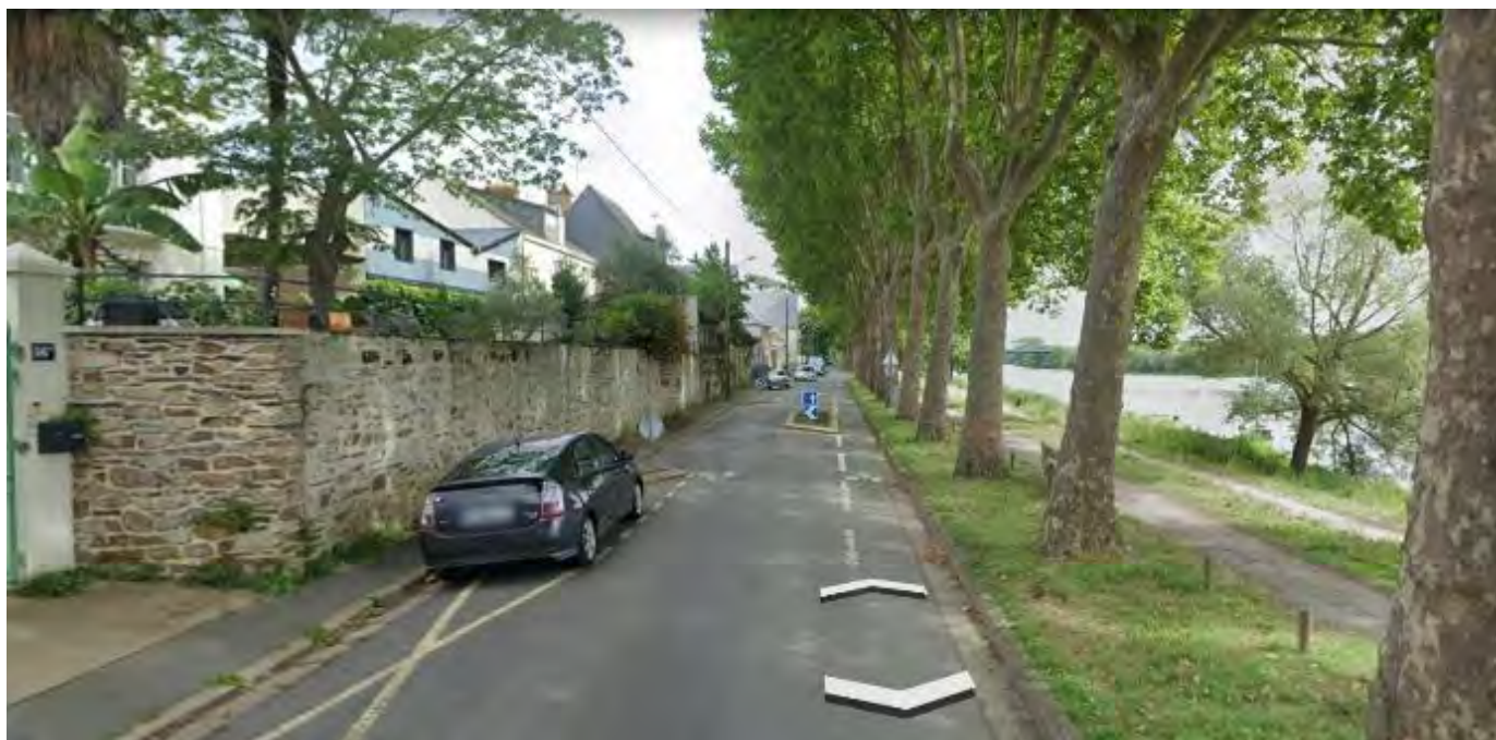
Figure 62 : Vue de la Promenade de Reculée avant aménagement
