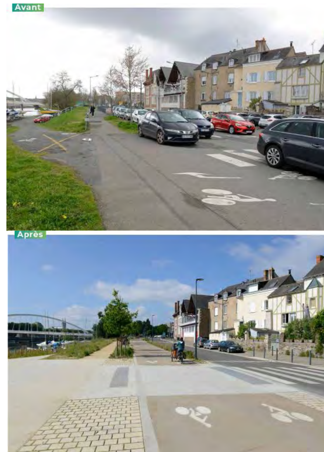
Figure 46 : Vues avant/après des aménagements Promenade de Reculée – cercle de voile
