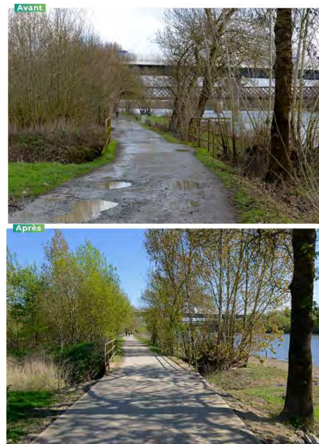
Figure 48 : Vues avant/après des aménagements Promenade de Reculée – Saint Aubin
