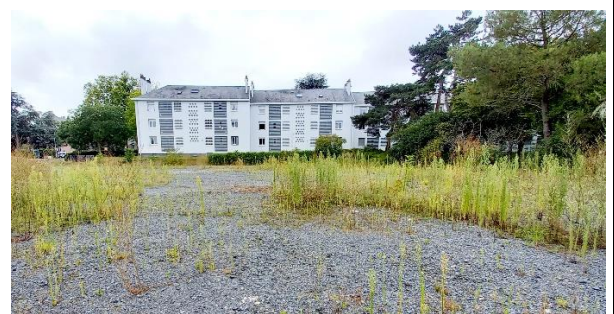
Partie issue de démolition (est)
