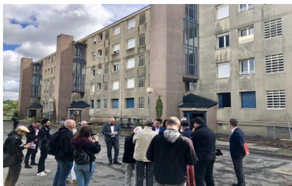
Destruction de la tour en 2019
