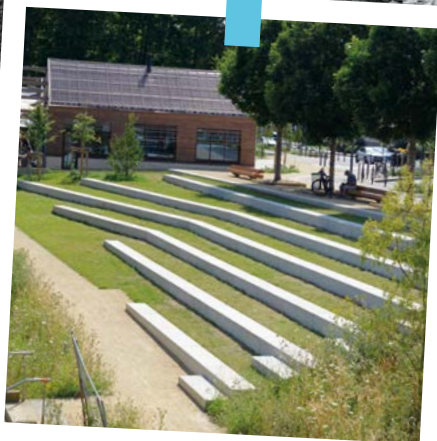
Aménagements des gradins devant le CHU
