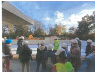
VISITE DU CHANTIER DE LA PISCINE PROPOSÉE AUX HABITANTS
