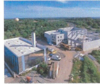
Construction de la nouvelle chaufferie Mayenne 2
