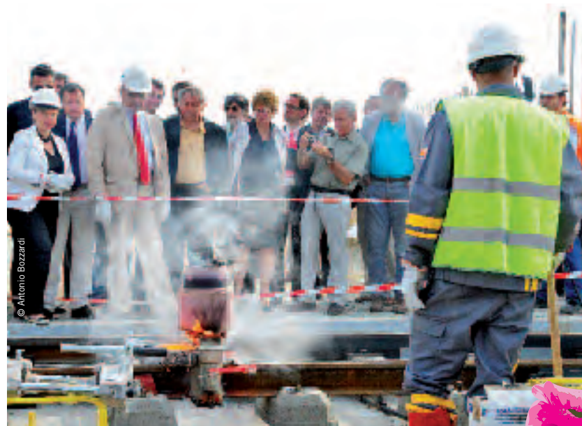
les travaux de réseau ont laissé place à l'aménagement de la plate forme du tramway et à la pose des rails. Depuis le mois de septembre, sur l'avenue Mendès-France et la rue des Capucins, les soudeurs ont pris le relais.
