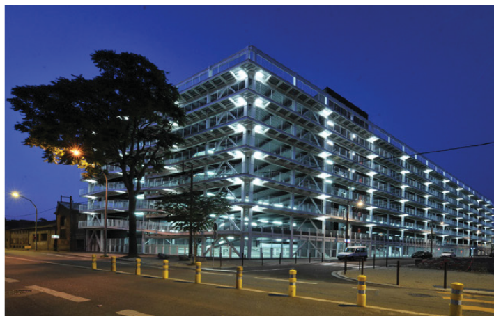
Parkings mutables de l'écoquartier de la Cartoucherie (Toulouse) et de l'île de Nantes : travail sur les hauteurs sous plafond et les structures démontables
