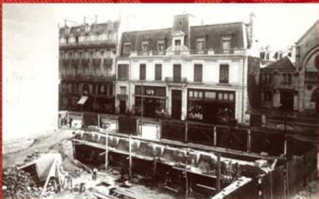
Nouvelles Galeries , rue d'Alsace : chantier de construction. Vers 1899. Photographie. Arch. mun. Angers, coll. Robert Brisset, 9 Fi supplément.
