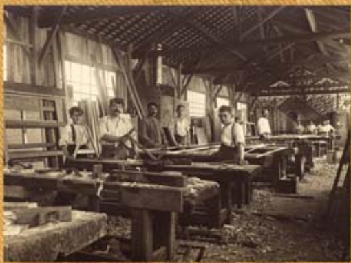
Vue intérieure des ateliers André. Vers 1911. Photographie. Coll. part.
