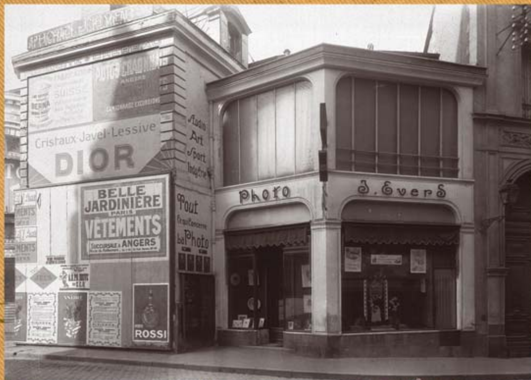
Magasin et atelier, 4 rue Saint-Denis. Vers 1920. Photographie. Coll. Pascal Guiraud.
