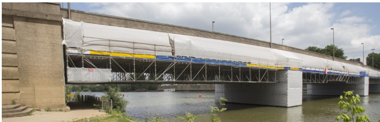
Rénovation du Pont de la Haute-Chaine
