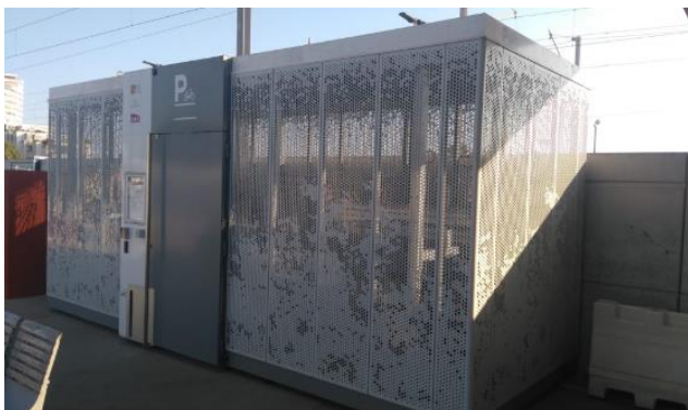
Parking à vélo accessible par badge abonné à Villeneuve-Loubet
