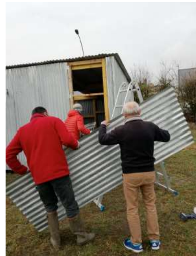
Chantier abris de jardin – Été 2017 Cueillette du Clos de Frémur
